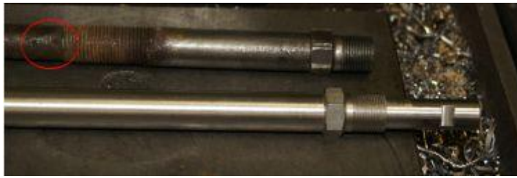
Zd. R2. Widok zdemontowanej tulei endoskopu (z zaznaczeniem perforacji) oraz wykonana nowa tuleja, przeznaczona do spawania do głowicy po frezowaniu
